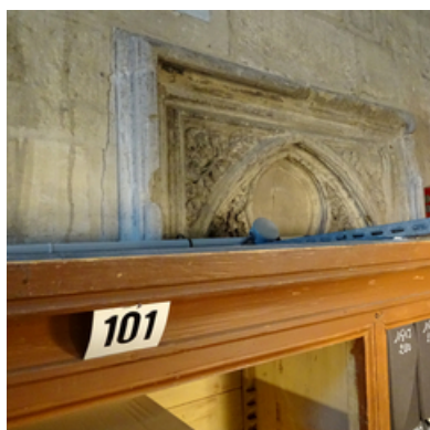
Détail architectural derrière les travées sur la mezzanine de la chapelle de Benoît XII, Palais des Papes, Avignon, 2024 (AD Vaucluse) © (AD Vaucluse)
