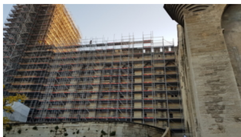
Échafaudage sur l'aile des Familiars et la tour de la Campanie du palais des Papes, 2021
